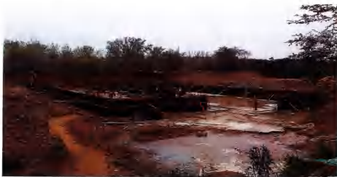
污水池立墙支模
