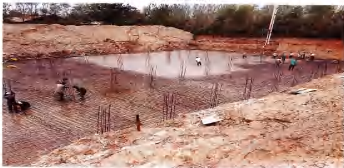
污水池底层防渗商混
