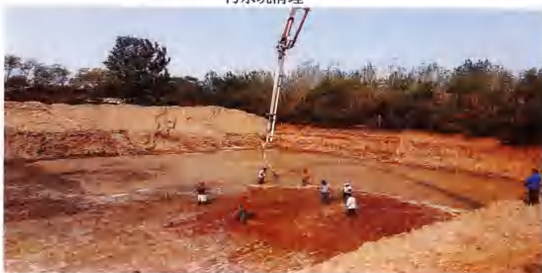
污水坑商混垫层
