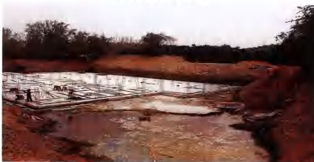
污水池底层商混完成
